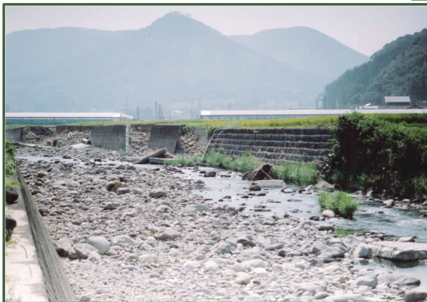
▶ かごマット非倒壊写真
