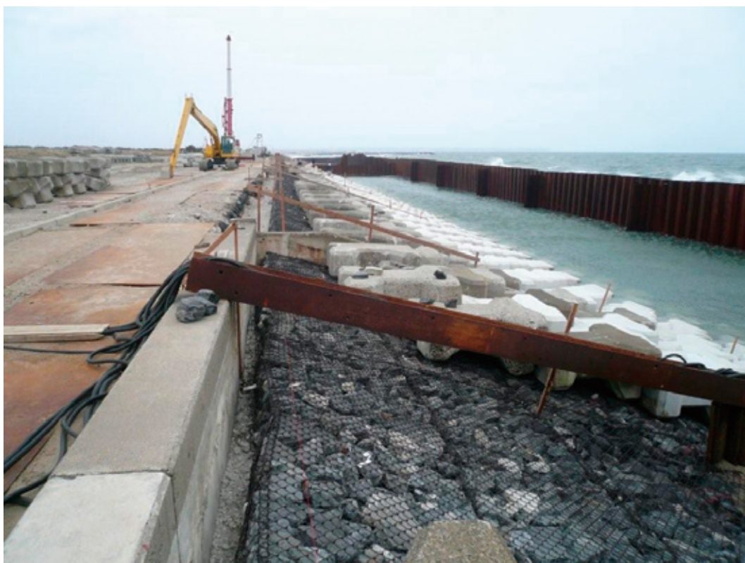
写真3 千葉県 2012 (緩傾斜堤)
