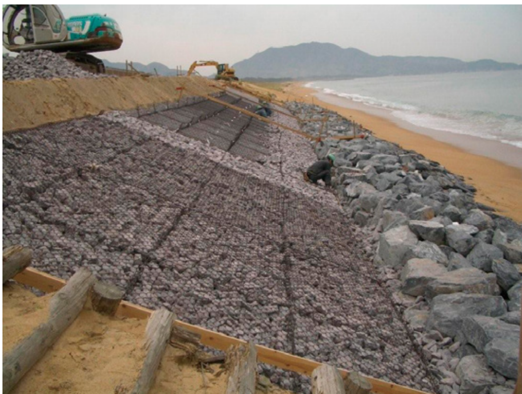
写真4 福岡県北九州 2006 (緩傾斜堤)
